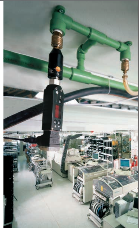
Bei kritischen Anwendungen überwacht das testo 6740 die Druckluftfeuchte direkt vor dem Verbraucher – z.B. in der Elektronikfertigung.
